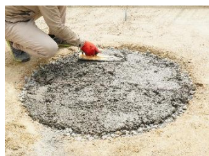
平らに押し固めて水平をとる
