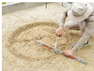
サークルストーンが 地表の高さに合うように穴を掘る
