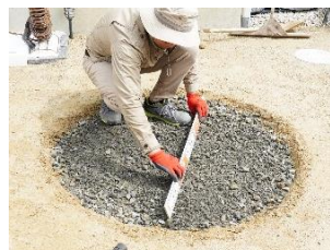
平らに押し固めて水平をとる
