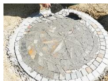
目地材(モルタル)を隙間に入れる
